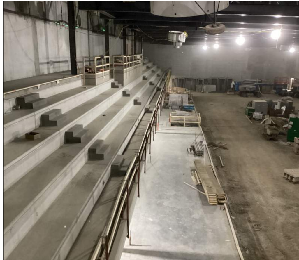
Auxiliary Ice Rink Slab on Grade Pour and Cast In Place Steps Pour
